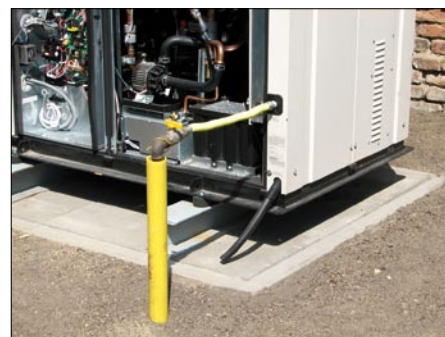
Elastyczne podłączenie instalacji gazowej do GHP
